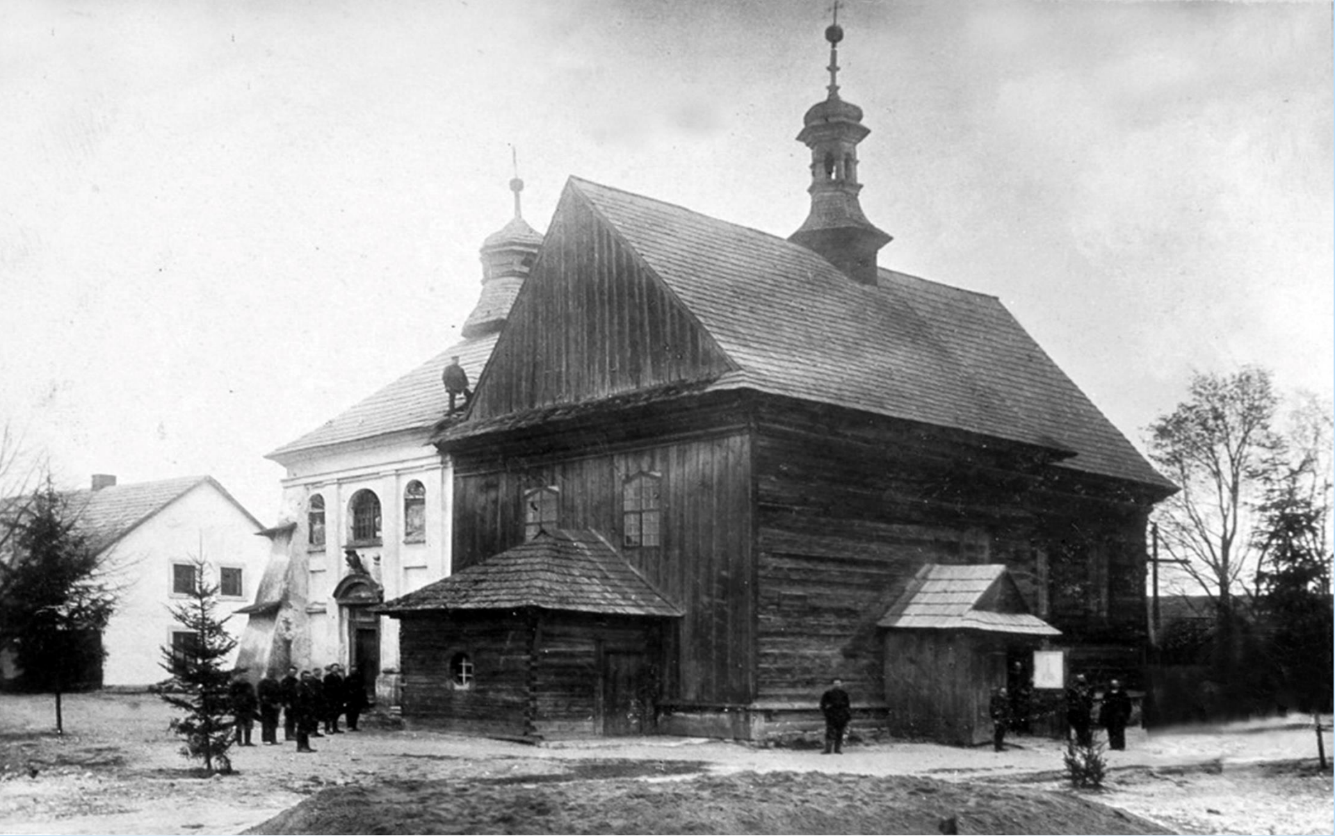
Kościół parafialny pw. św. Doroty. W środku murowana kaplica Matki Bożej Szkaplerznej z 1645 r. Z lewej budynek organistówki. Zdjęcie sprzed 1908 r.
