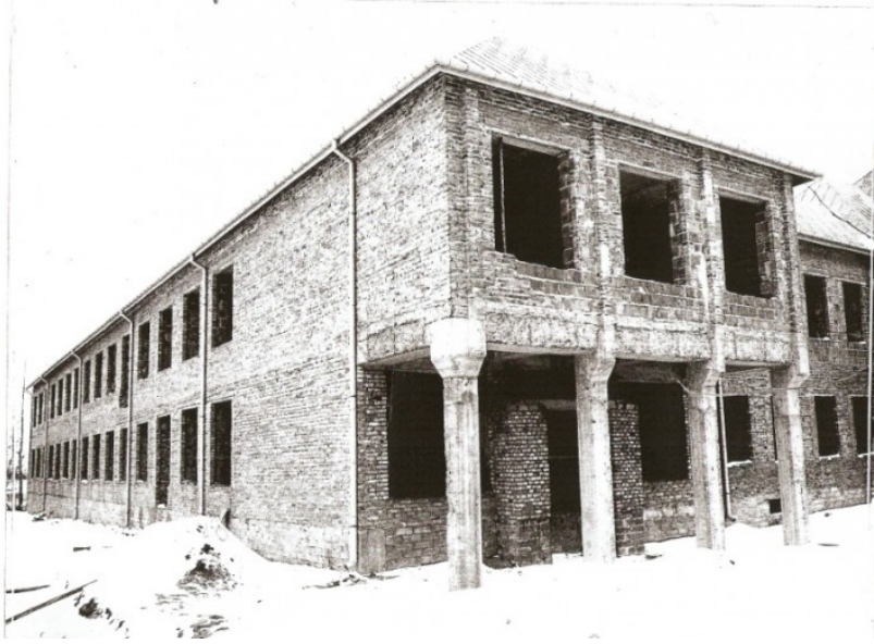
Widok nowego skrzydła szkoły w styczniu 1991 roku.
