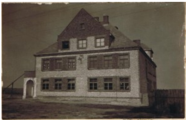
Budynek szkoły z 1948 roku
